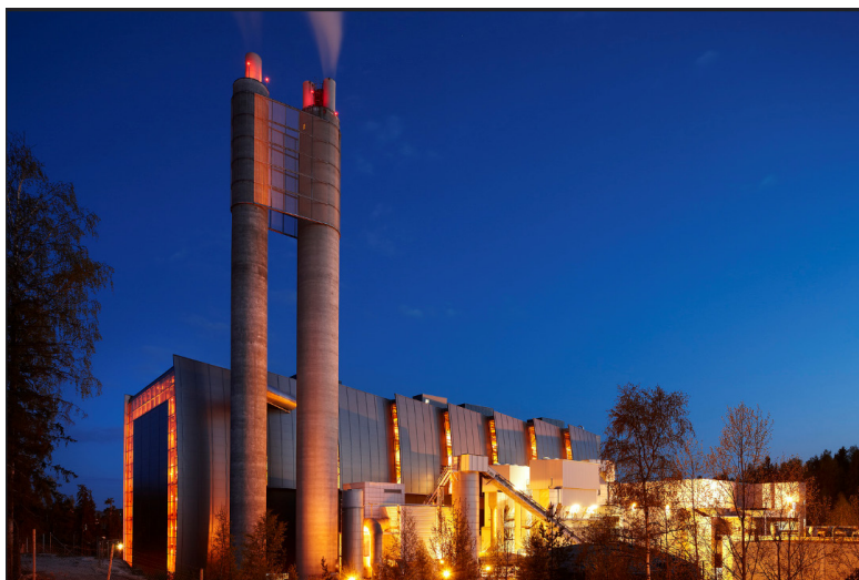
Figur 2. Klemetsrudanlegget er en av tre industrikilder for CO 2 i det norske fullskalaprojektet (Kilde: Fortum Oslo Varme)
