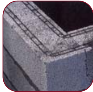
Fig. 1 og 2: Til murte kjellervegger (med Lettklinkerblokker) brukes vanligvis delte liggefuger og ingen vertikalfuge.
