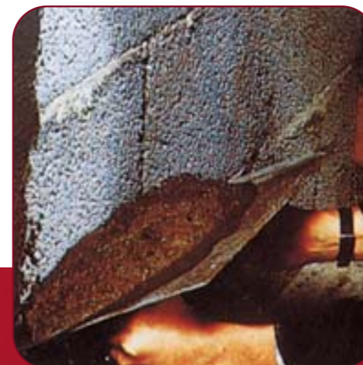
Fig. 3 Påtrekket utføres ved at mørtelen trekkes på muren med stål- eller trebrett i 8-10 mm tykkelse. Etter at mørtelen har satt seg, bruker du rettholt eller trebrettet til å jevne ut pussflaten.
