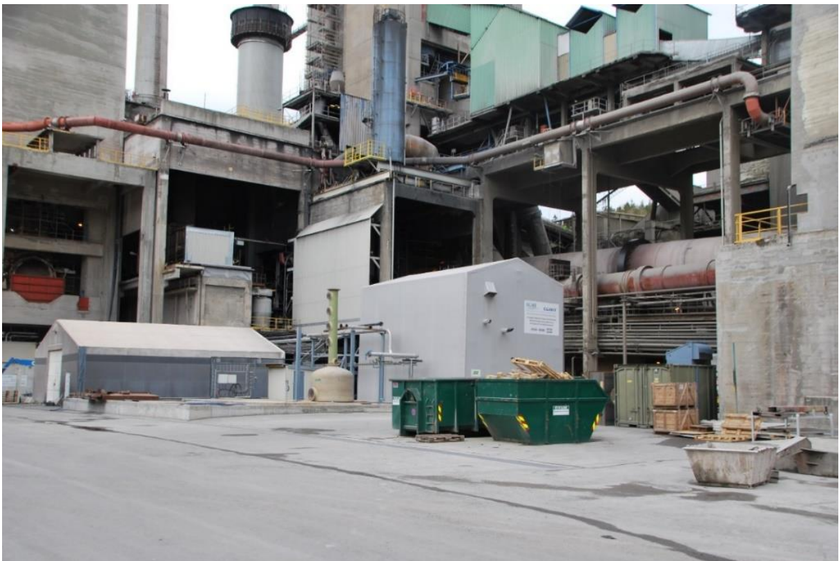
Figur 3-1: Fangstanlegget er planlagt i dette området inne på Norcems fabrikk
